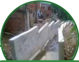
Canalización de quebrada y construcción de alcantarillado no convencional, quebrada La Mística $600 millones
